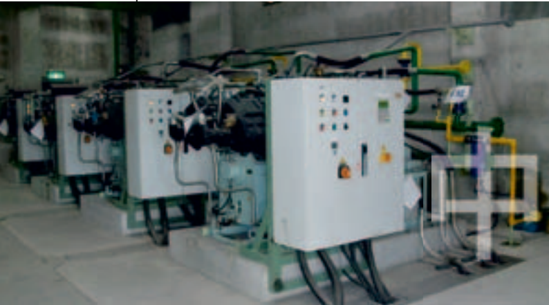
Sauer & Sohn Stickstoff- und Argon-Booster im Stahlwerk der Dragon Steel Corporation. Sauer & Sohn's nitrogen and argon boosters at the Dragon Steel Corporation's steelworks.
